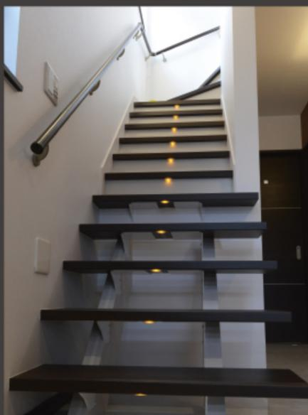
ほたるライト付き階段は、踏み板の中央部にLEDを搭載。段差部を見分けやすく照らすため、深夜の昇降も足下を確実に照らす事により安全に導きます。
